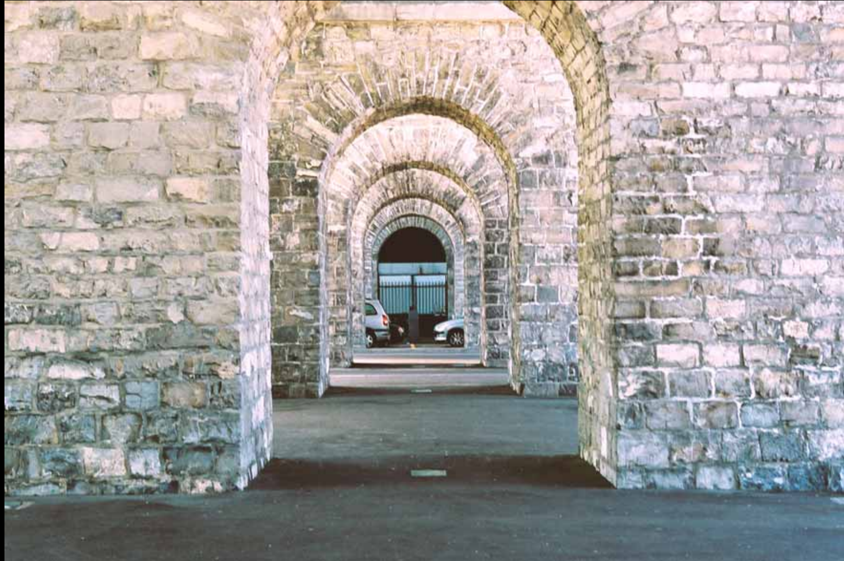
Grand-Pont. Construction à l'est
