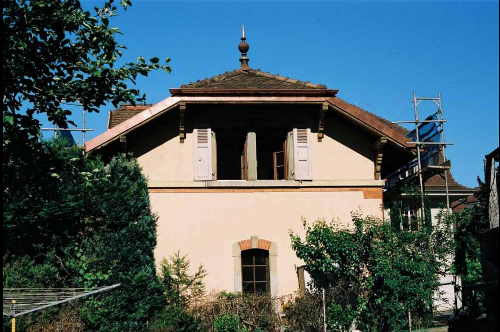
Chemin Suchet 5-7: toiture
