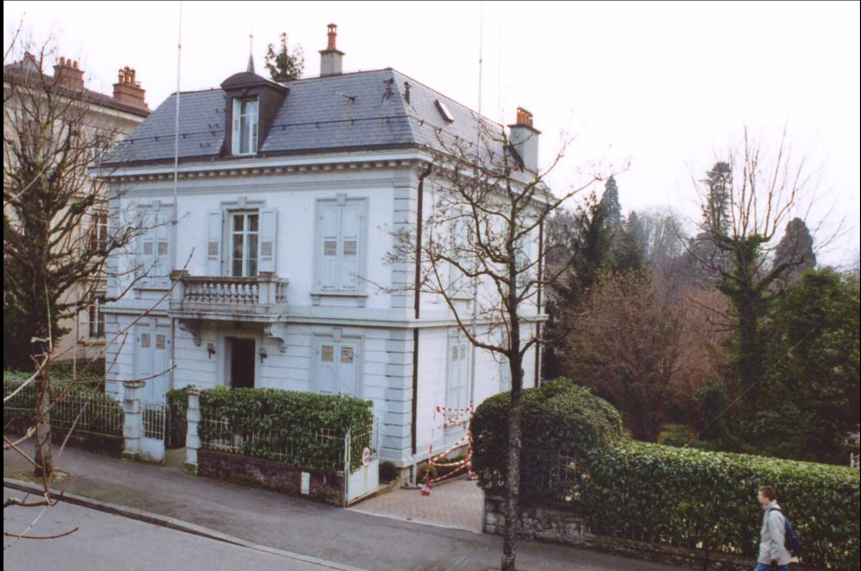
Mont d'Or 5: à réhabiliter
