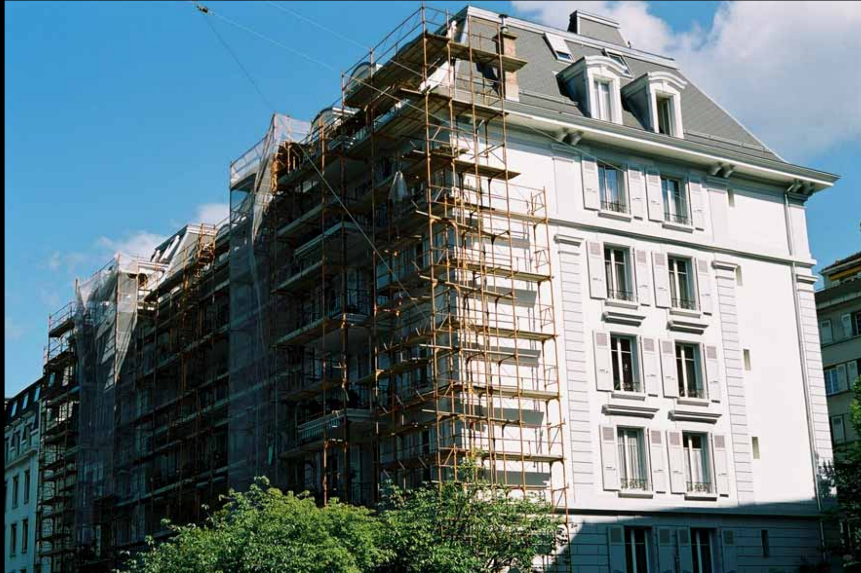
Av. Eglise Anglaise 16-20: toiture
