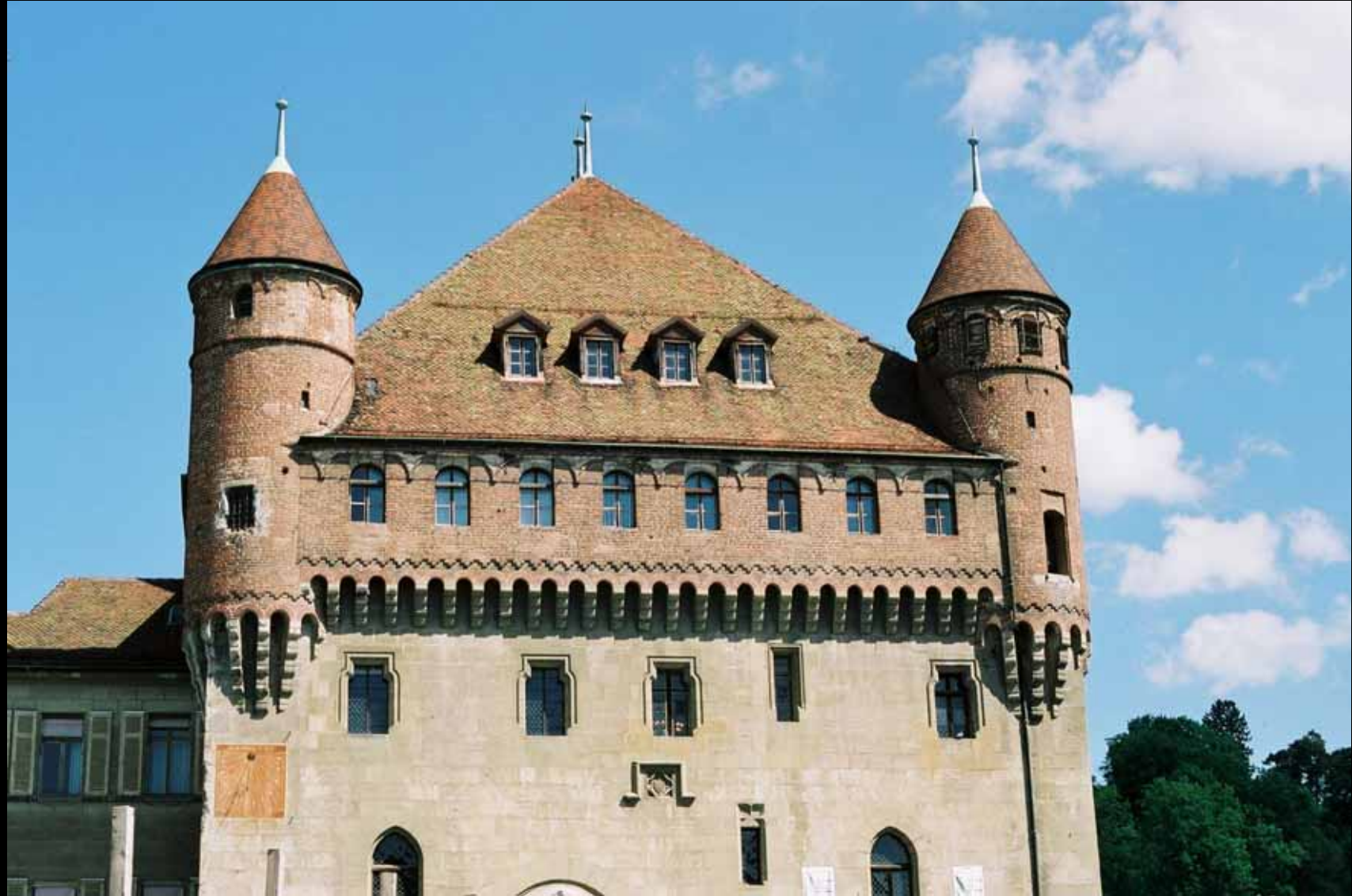
Château Saint-Maire. Installation sécurité
