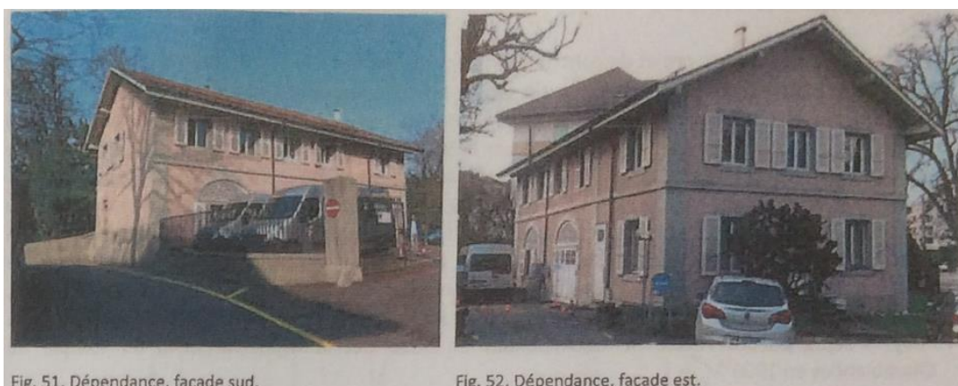
Fig. 51. Dépendance, façade sud.
