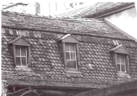
▲ Rue Vuillermet 4 Toit à la Mansart, remontant selon toute vraisemblance au XVIII e siècle (état janvier 1999)
