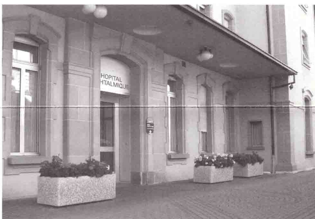
Hôpital ophtalmique, avenue de France. Cour nord (état octobre 2004)
