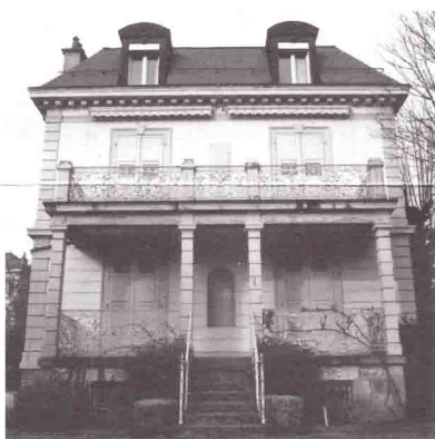
Villa Mont d'Or 5, façade sud.
