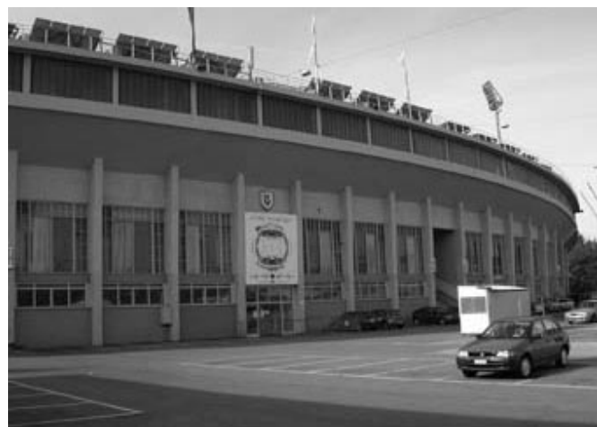
Le stade olympique, état novembre 2006.
