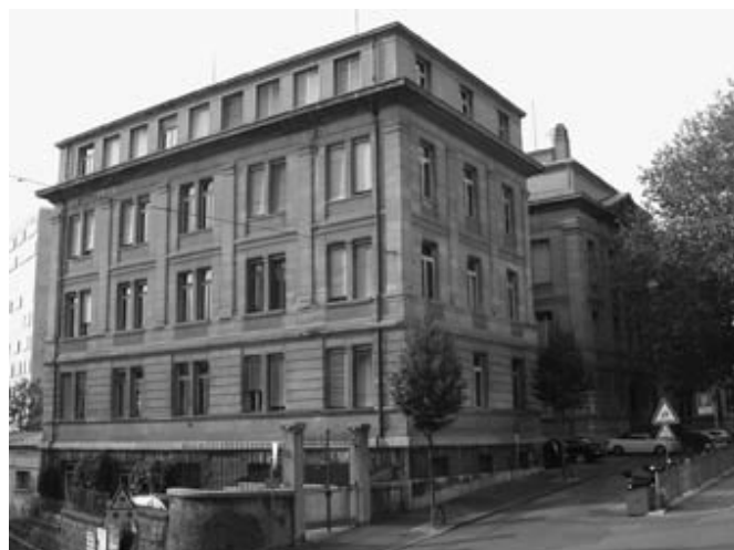
Collège de Villamont, façade nord. Etat novembre 2006.
