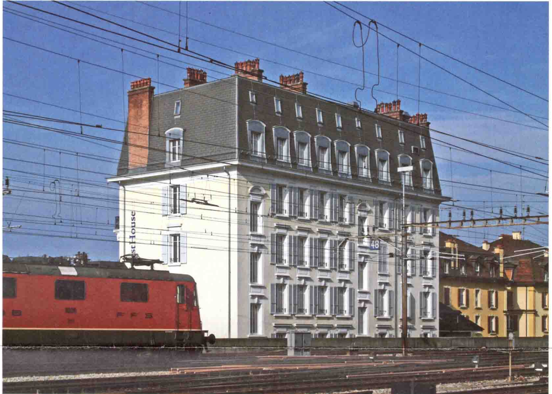
L'immeuble abritant le Lausanne Guesthouse devra disparaître en raison du projet Léman 2030.
