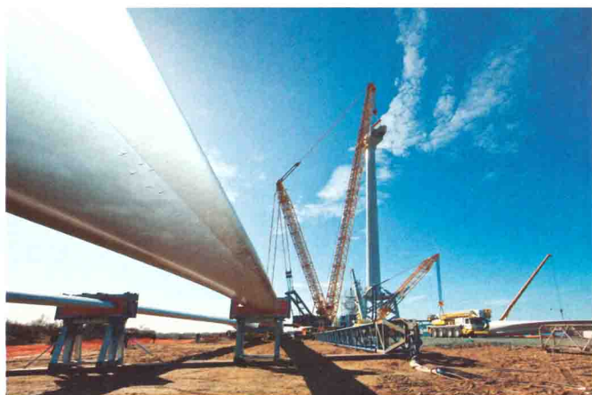
L'emprise du chantier de construction d'une éolienne de grande puissance est dommageable pour les milieux naturels.
