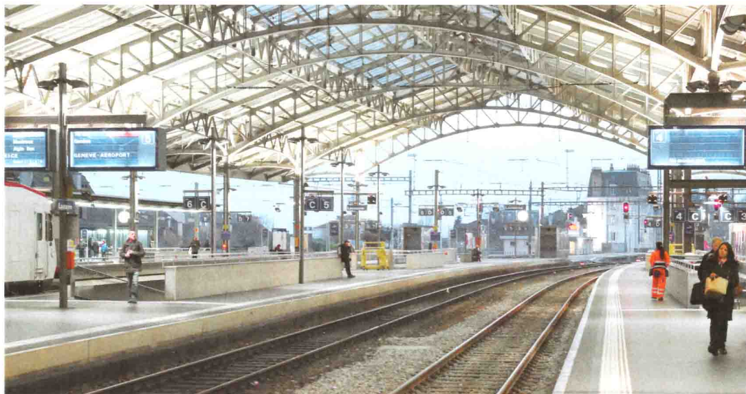
Gare de Lausanne, état avant travaux, le 16 mars 2016.
