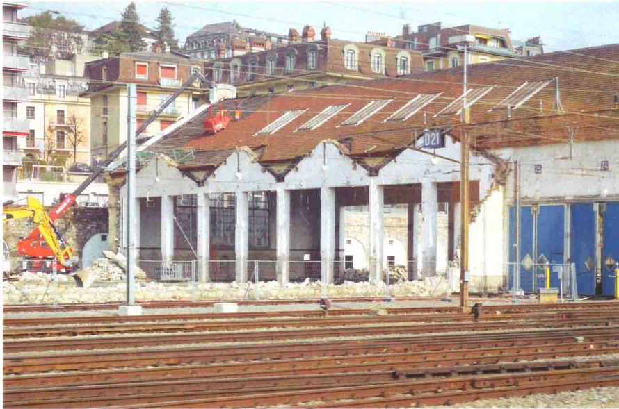
Gare de Lausanne, démolition du dépôt de locomotives, état du 26 février 2016.
