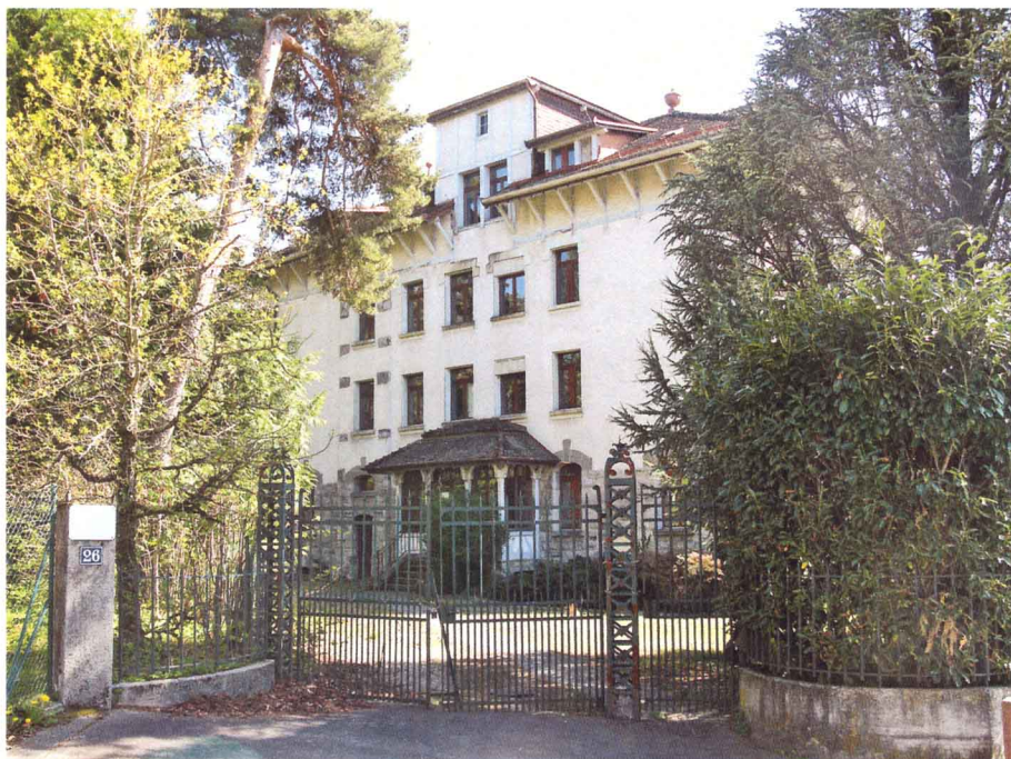
Immeuble chemin Isabelle-de-Montolieu 26. Ancien Institut Valcreuse. Etat avril 2017.
