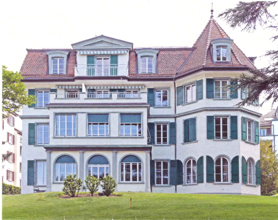
Villa Collonges, façade sud. Etat mai 2018.
