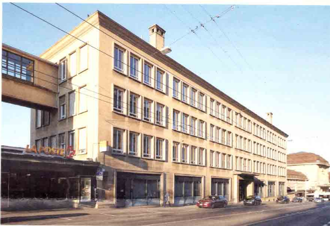
Av. de la Gare 45, œuvre de l'architecte Alphonse Laverrière, bâti en 1949-1950. Photo J. Bieger.
