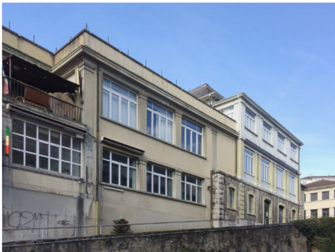
Villa Haute-Rampe, façade côté du levant. La partie avec le soubassement en pierres de taille est la maison d'origine. Etat 2023. Photo F. Mercanton
